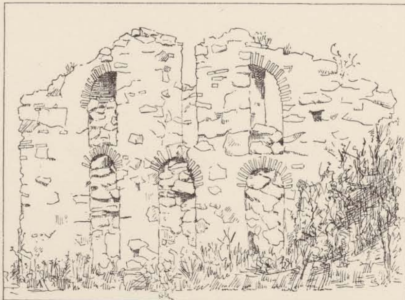
7. Réfectoire : façade Ouest.
