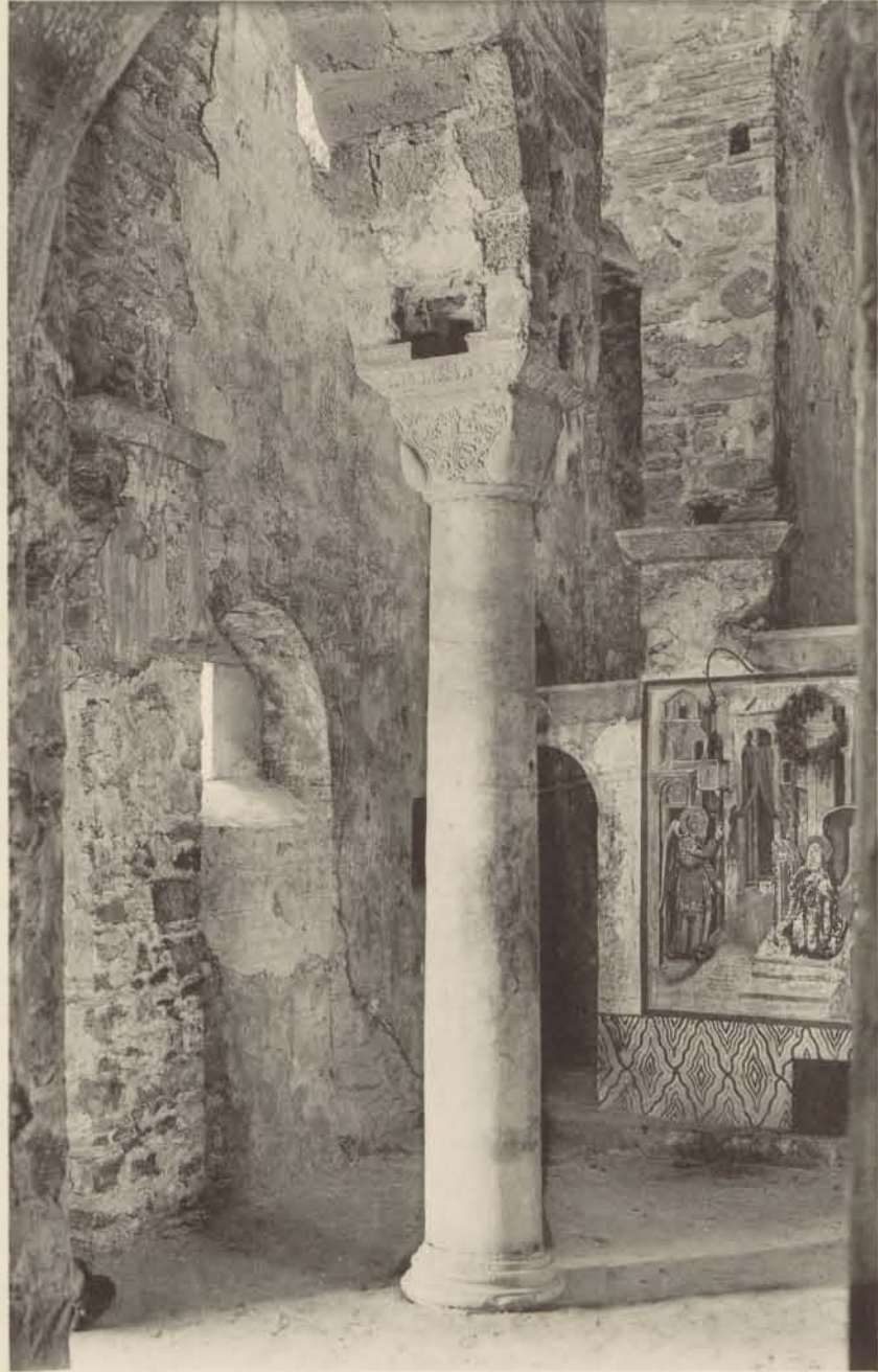
1. Vue de l'intérieur (angle Nord-Est).
