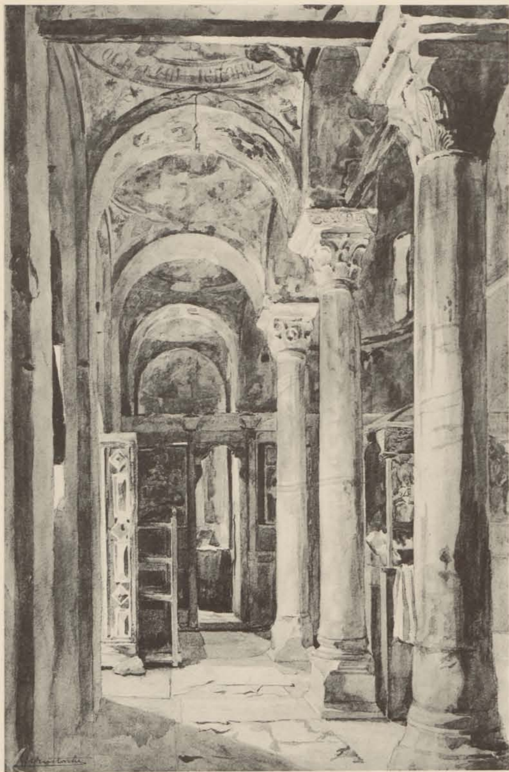
1. Vue du bas-côté Nord.
