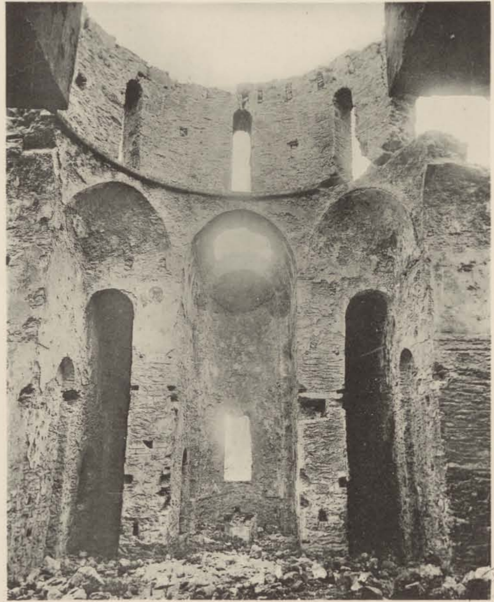
4. Vue intérieure des absides.
