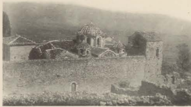
2. Vue prise du Sud-Ouest.
