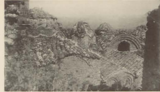
2. Toiture vue du Sud-Ouest.
