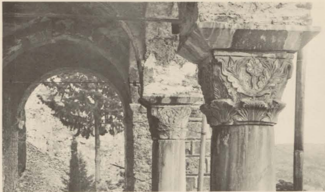
2. Chapiteaux du portique Nord.
