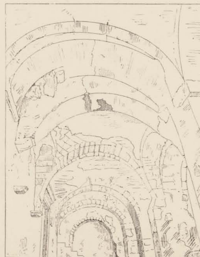
7. Portique Ouest de la Métropole.
