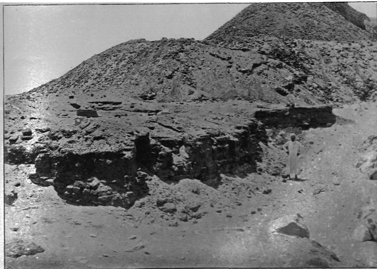
Tranchée au nord de la pyramide. — 15 Mars.
