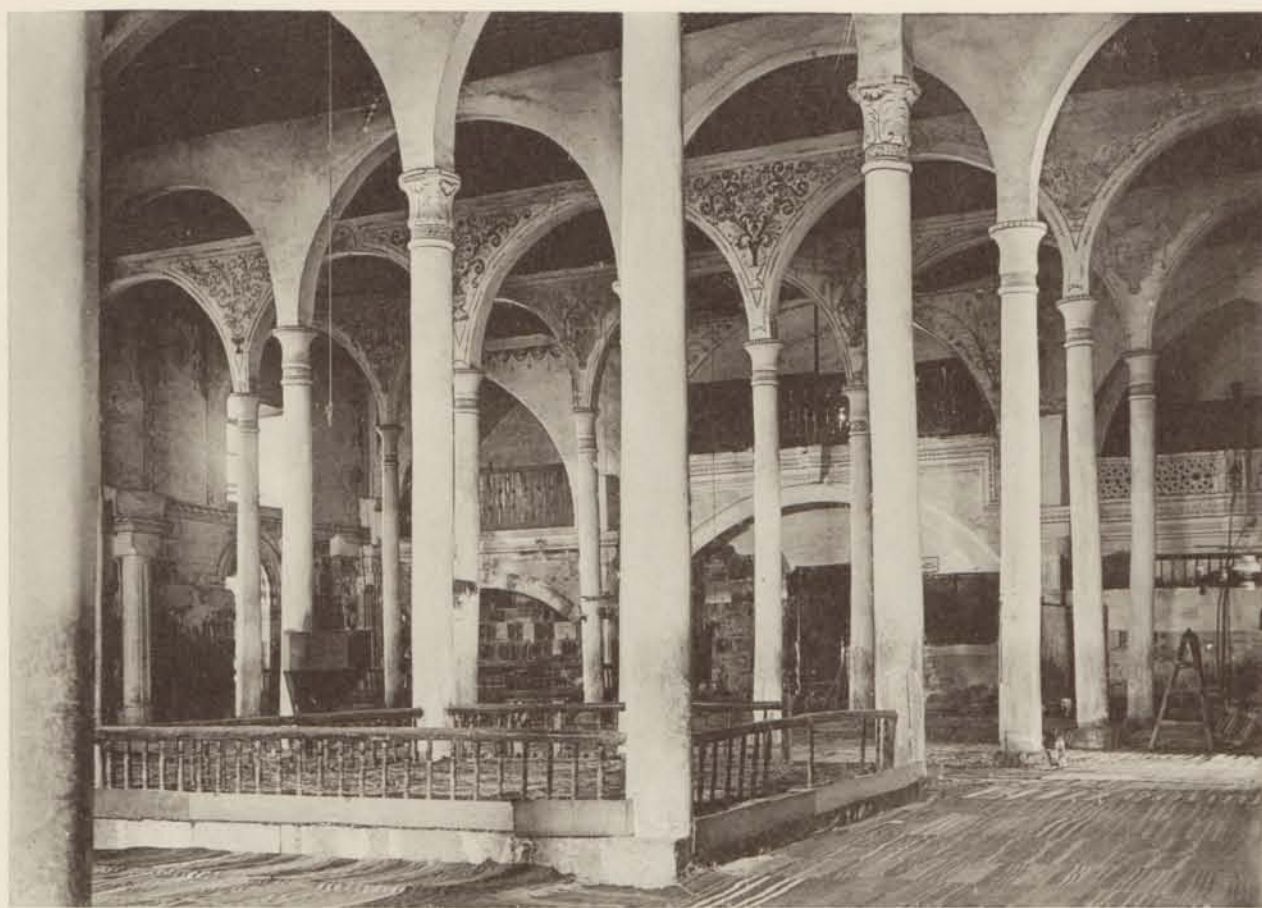
1 - INTÉRIEUR : VUE D'ENSEMBLE.
