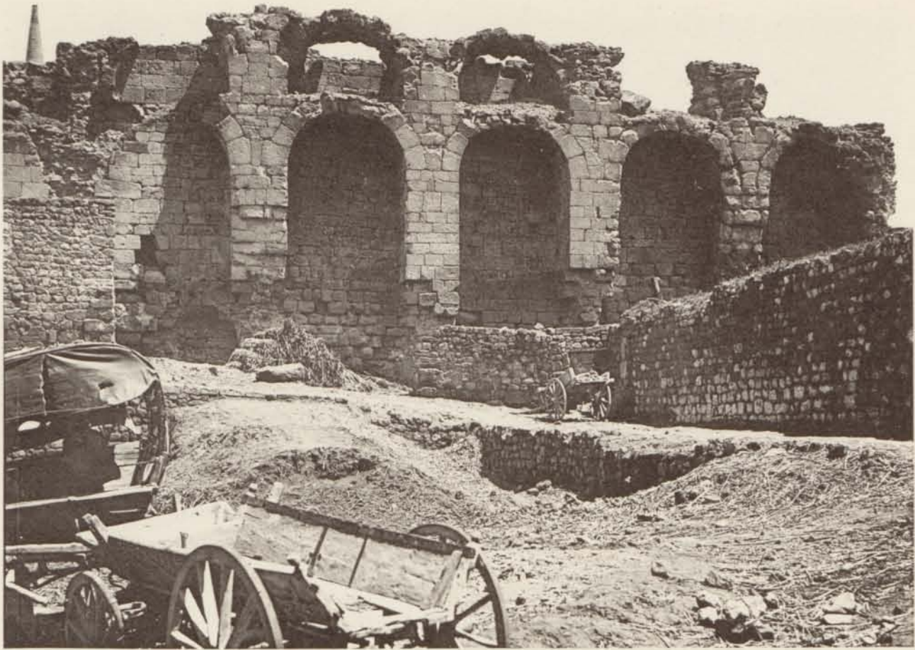
1 - ENCEINTE DE LA VILLE : COURTINES DU NORD-EST (FACE INTERNE).
