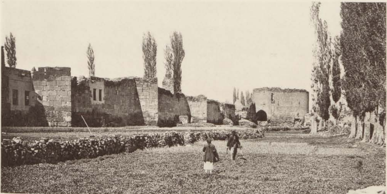
2 - ENCEINTE DE LA VILLE : COURTINES DU SUD-EST.
