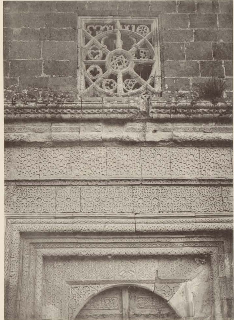
2 - PORTE DU NORD : DÉTAIL.
