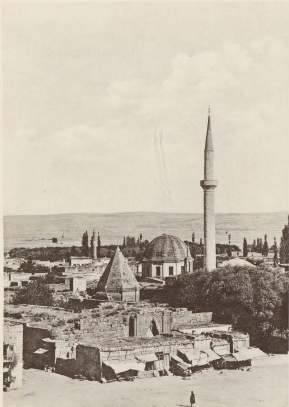
1 - VUE D'ENSEMBLE : MEDRESSÉ, TURBÉ ET MOSQUÉE.
